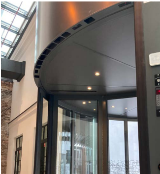
Horisontell luftridå med diffusor integrerad i takskärm
