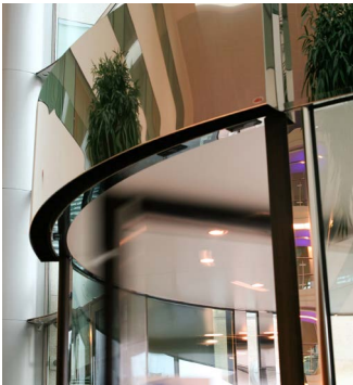
Horisontell luftridå med böjd diffusor utanpåliggande i nivå med takskärm.
