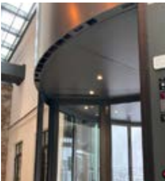
Horisontell luftridå med diffusor integrerad i takskärm
