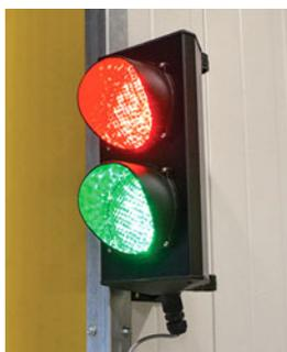
Il sistema di semafori è provvisto di un sensore sopra alla pedana di carico oppure di un cuneo bloccaruote, per il rilevamento della presenza dei veicoli.
