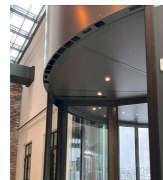
Lama d'aria a livello orizzontale con diffusore integrato nel ciellino
