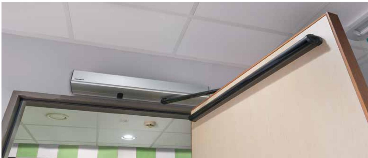
ASSA ABLOY SW100 peut être monté des deux côtés de la porte à automatiser, afin de l'ouvrir par traction ou par poussée. Il est conçu pour les portes battantes simples ou doubles.
