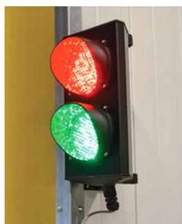
El sistema de semáforo tiene un sensor encima de la plataforma que detecta la presencia del vehículo, o bien es un calzo de rueda que detecta el vehículo. Si no hay ningún vehículo (es decir, si la plataforma está libre), el semáforo interior está en rojo y el exterior en verde. El semáforo también se puede combinar con un calzo de rueda o un interbloqueo de puerta/plataforma.
