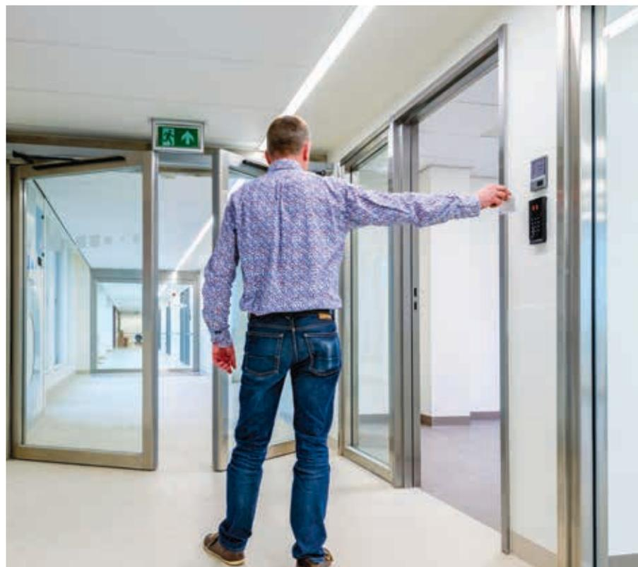
■ Porta automatica interna a battente con controllo accessi
