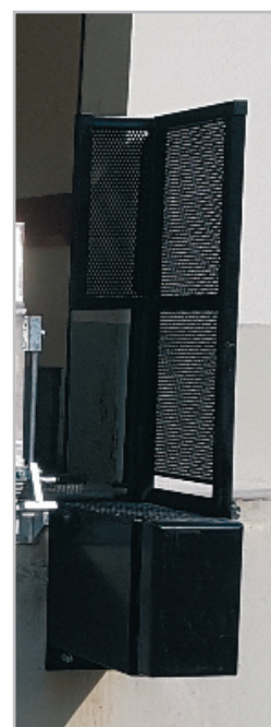
Création d'un espace de sauvegarde de 500 mm conformément aux recommandations Carsat et INRS
